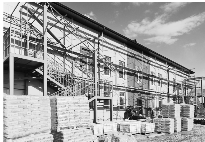
Строительство детского сада в Шовгеновском районе
