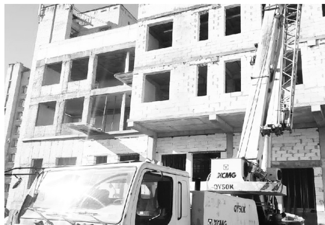
Строительство поликлиники в микрорайоне «Восход» г. Майкоп
