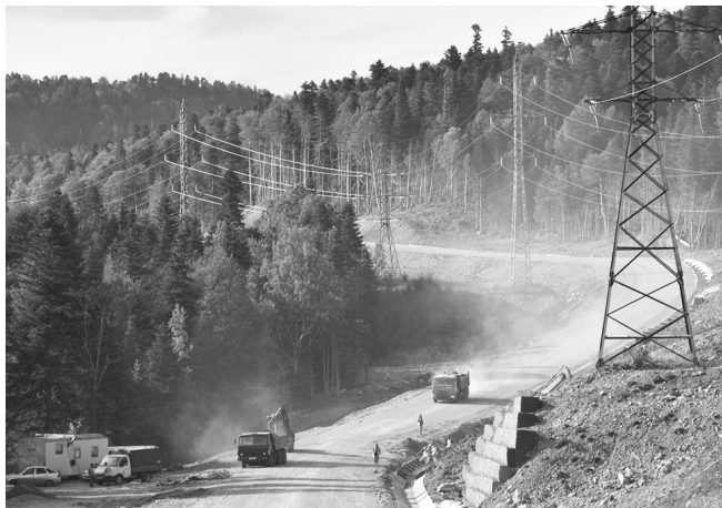
Строительство автодороги к плато Лаго-Наки
