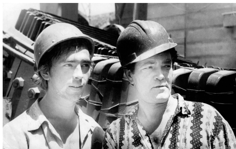
На фото: Старолад Иван Иванович (справа) на строительстве Гергебильской ГЭС (Дагестан)
