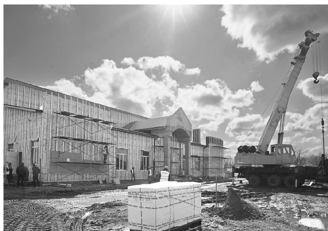
Строительство Дома культуры в ауле Хатажукай Шовгеновского района
