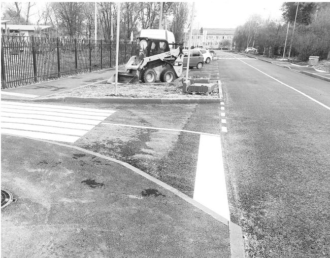
Обустроена дорога по улице Рабочей
