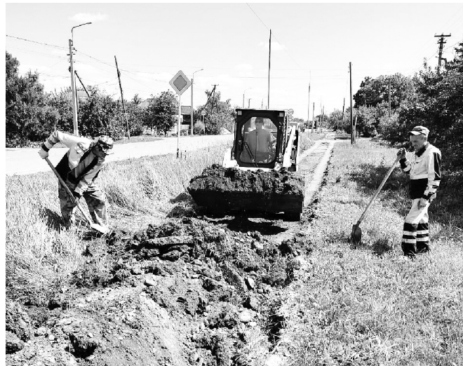
Строительство тротуара по улице Красной
