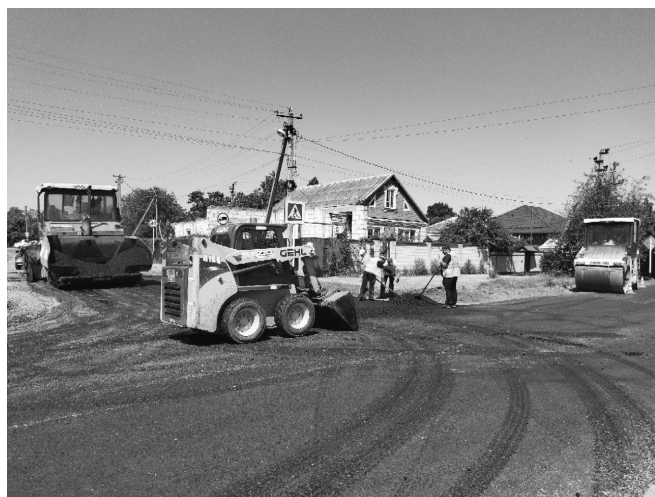
Ремонт дороги улицы М. Горького в ст. Гиагинской
