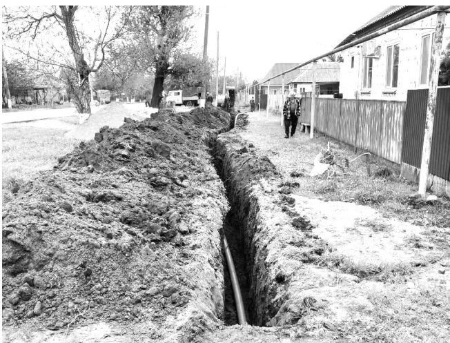
Строительство водопровода в ст. Дондуковской
